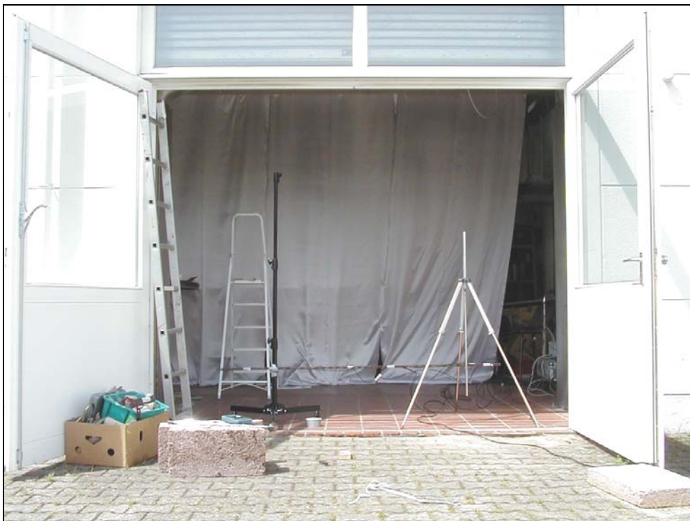
Bild 1: Werkhallentor bei der Firma LWT mit Torwandanlage
