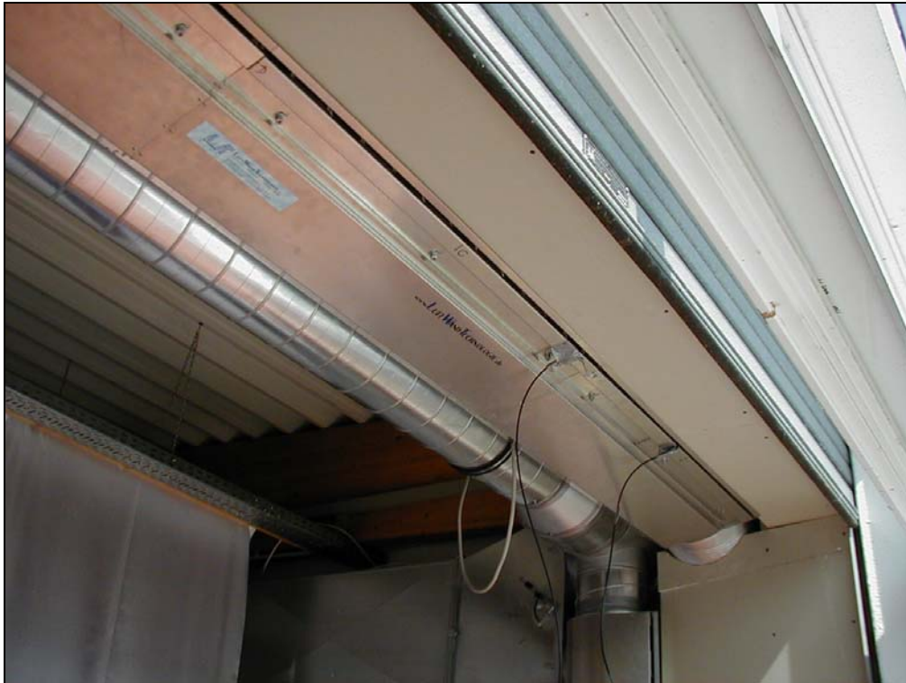
Bild 2: Schlitzauslassdüse mit Einblasrichtung von oben nach unten
